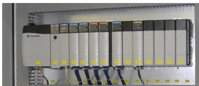
Фид. 2. Система за управление базирана на програмируем логически контролер (PLC)
