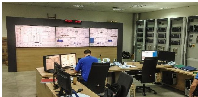
Фид. 4. DCS система за управление
