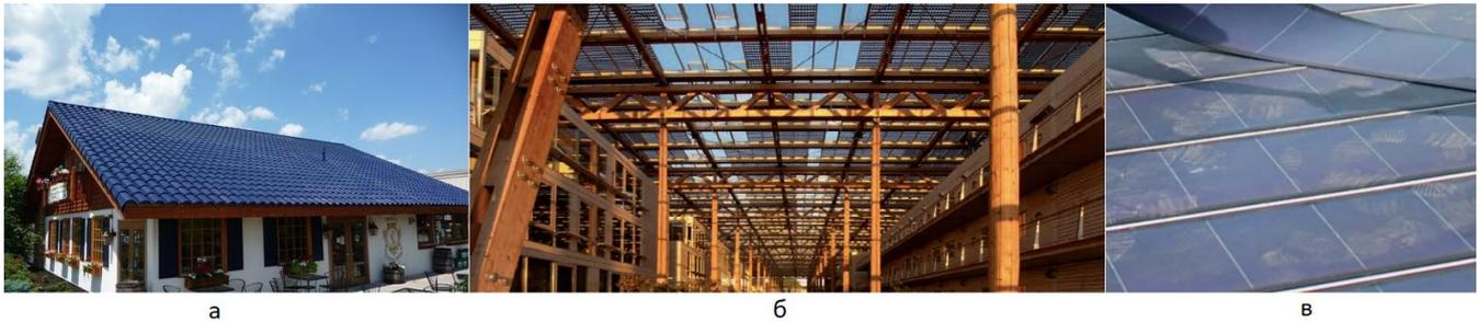
Фиг.1. а –подмяна на покривното покритие със соларни модули; б – интегриране на фотоволтаични системи чрез използване на прозрачни или полупрозрачни фотоволтаични модули; в - интегриране на фотоволтаични системи чрез полагане на фолиращи продукти.
