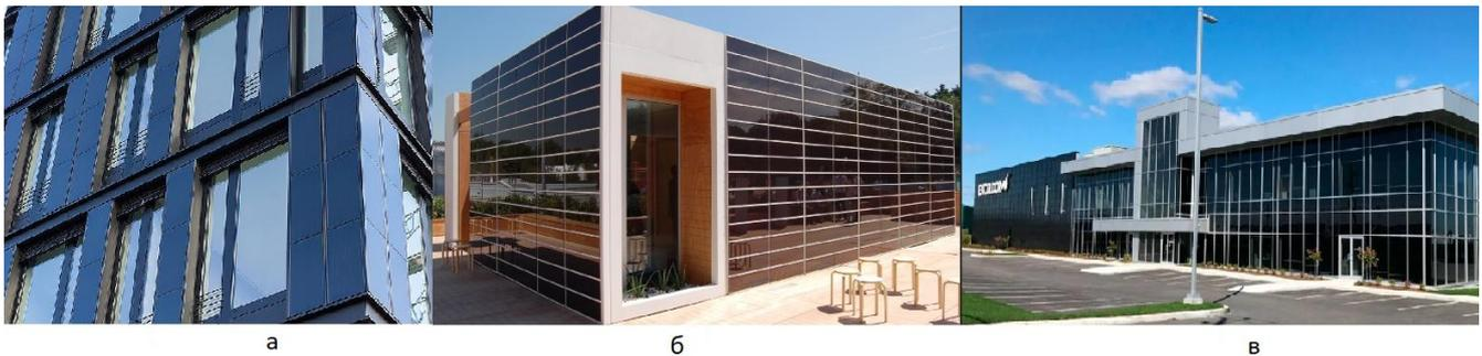
Фиг.2. а – вграждане на фотоволтаични модули чрез външно покритие; б – вграждане на фотоволтаични модули във вентилирани фасади; в - вграждане на фотоволтаични модули в завесни стени.
