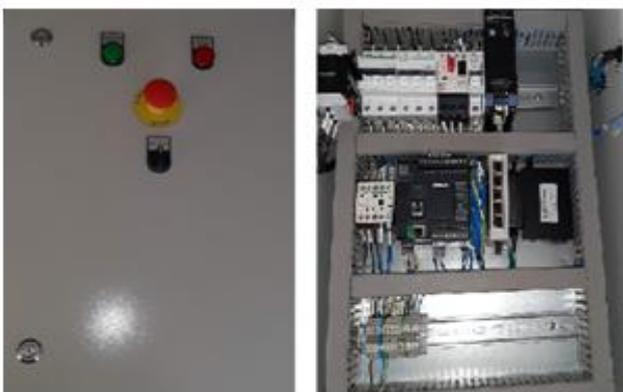
Fig. 2. Електрическо табло на автоматизираната система
