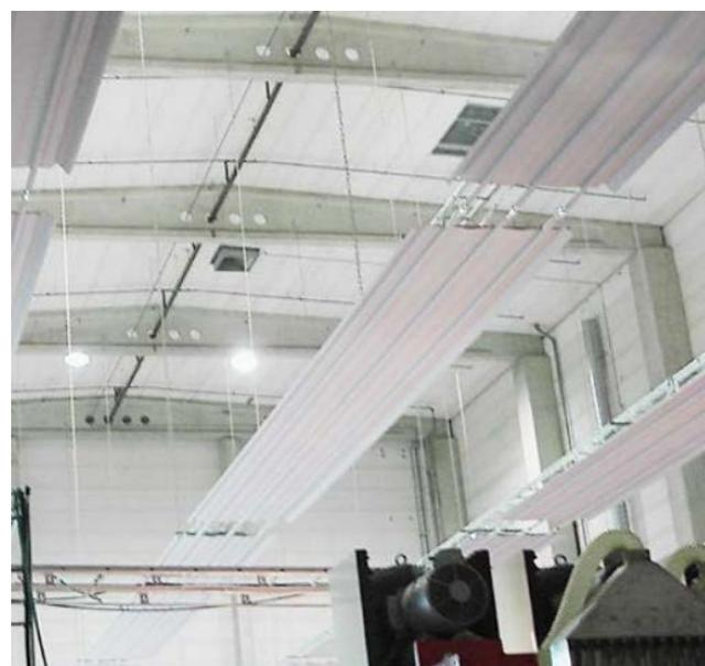
Фиг. 6. Инфрачервено тръбно отопление (снимка: Frico Ltd.)
